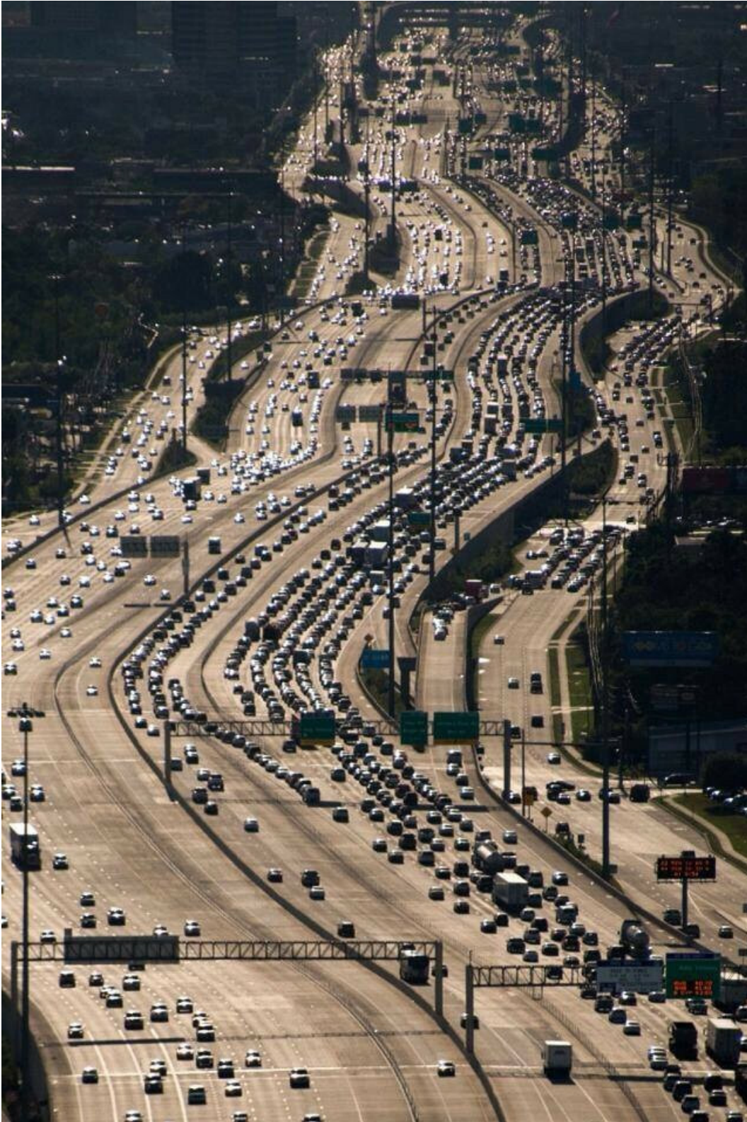
L'exemple de la Katy Freeway à Houston : malgré ses 26 voies elle n'a pas permis de résoudre les problèmes de congestion à cause du trafic induit
